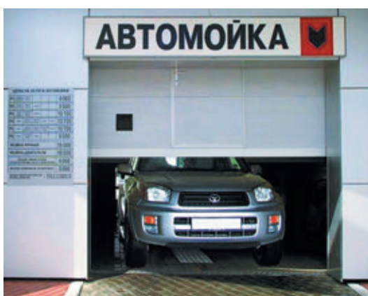
Секционные ворота «АЛЮТЕХ», установленные на автомойке.
