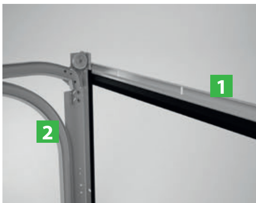
Планка-нащельник и направляющий профиль гаражных ворот
