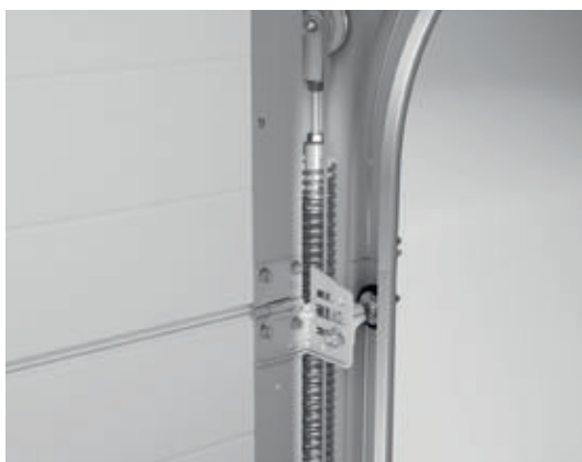
Пружина растяжения (гаражные ворота STANDARD)
